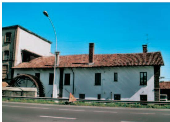
MULINO FIOCCHI, SULLA VIA EMILIA, TUTTORA ATTIVO. SI NOTI LA RUOTA IDRAULICA, IN FERRO, CHE UTILIZZAVA L'ACQUA DELLA ROGGIA SPAZZOLA.
